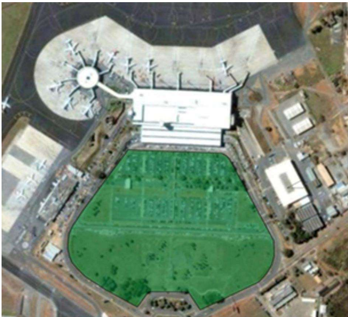
FIGURA 7 - Ampliação do estacionamento de veículos do Aeroporto Internacional de Brasília - Presidente Juscelino Kubitschek.
